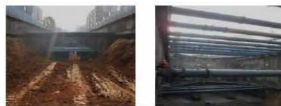
图2 钢支撑现场照片
